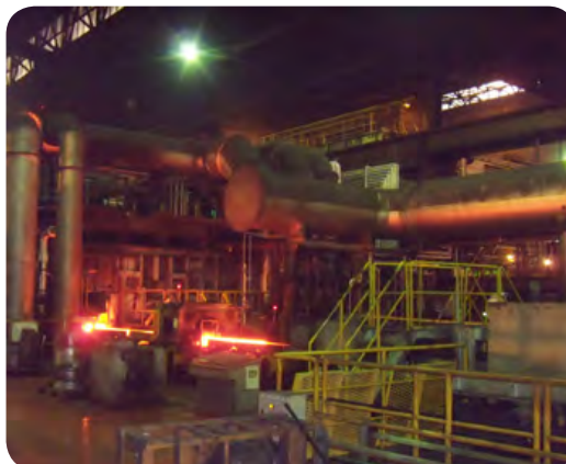
線材圧延加熱炉
