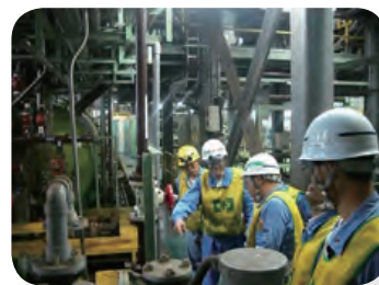
環境重点設備点検
