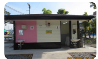
女性用トイレを新設（知多工場）
