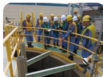
環境重点設備点検(星崎工場)
