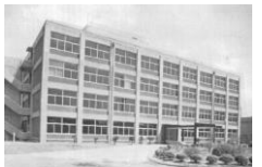
1968年、2階建てから4階建てに生まれ変わった中央研究所
