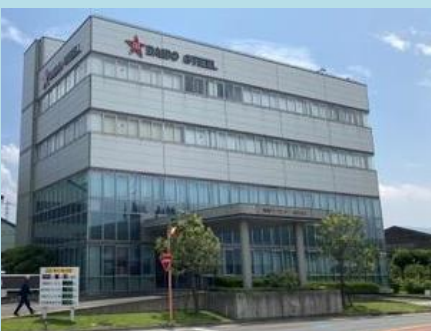
築地テクノセンター事務所(HEART) ：地域防災協力事務所
